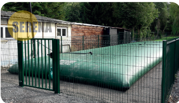
Bovengrondse brandblusinstallatie
